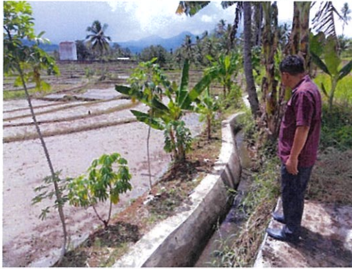
（財団補助金により整備された用水路）
