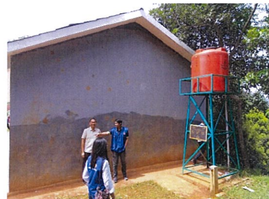
（整備された貯水タンク）
