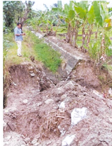
（修繕工事中の用水路）
